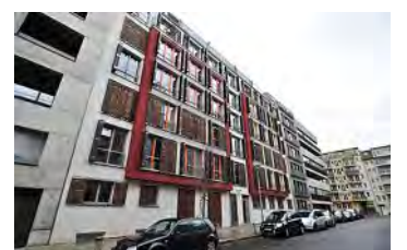
Zum Schutz Faltschiebeläden aus Holz sichern die Fenster
