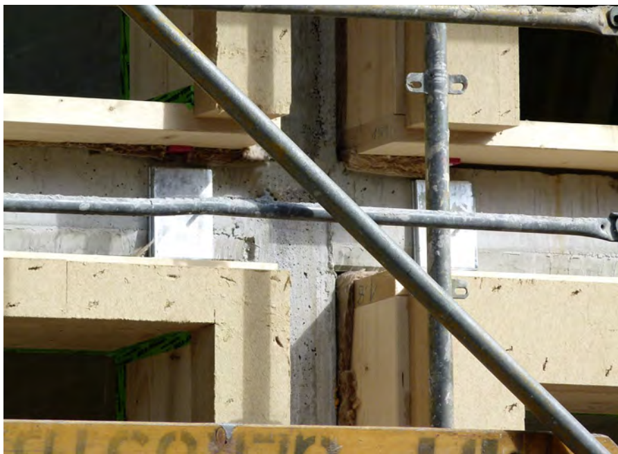
Die Holztafelelemente wurden in die etwas größeren Öffnungen des Betontragwerks eingesetzt und später Wärmebrückenfrei überdämmt.
